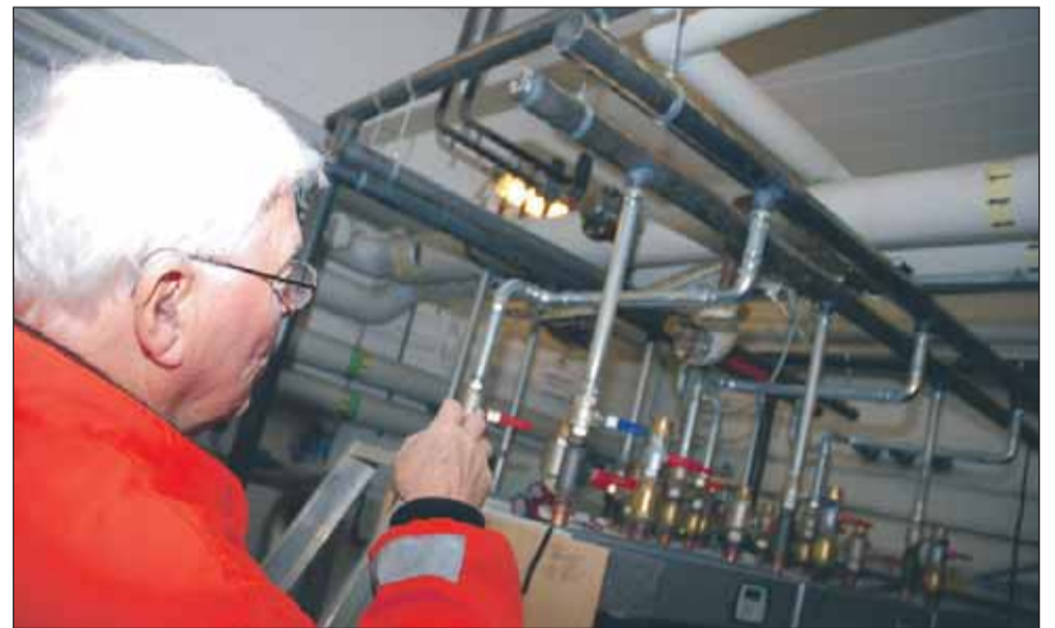
Gunnar övervakar tillkomsten av den nya uppvärmningsanläggningen i radhusområdet.
